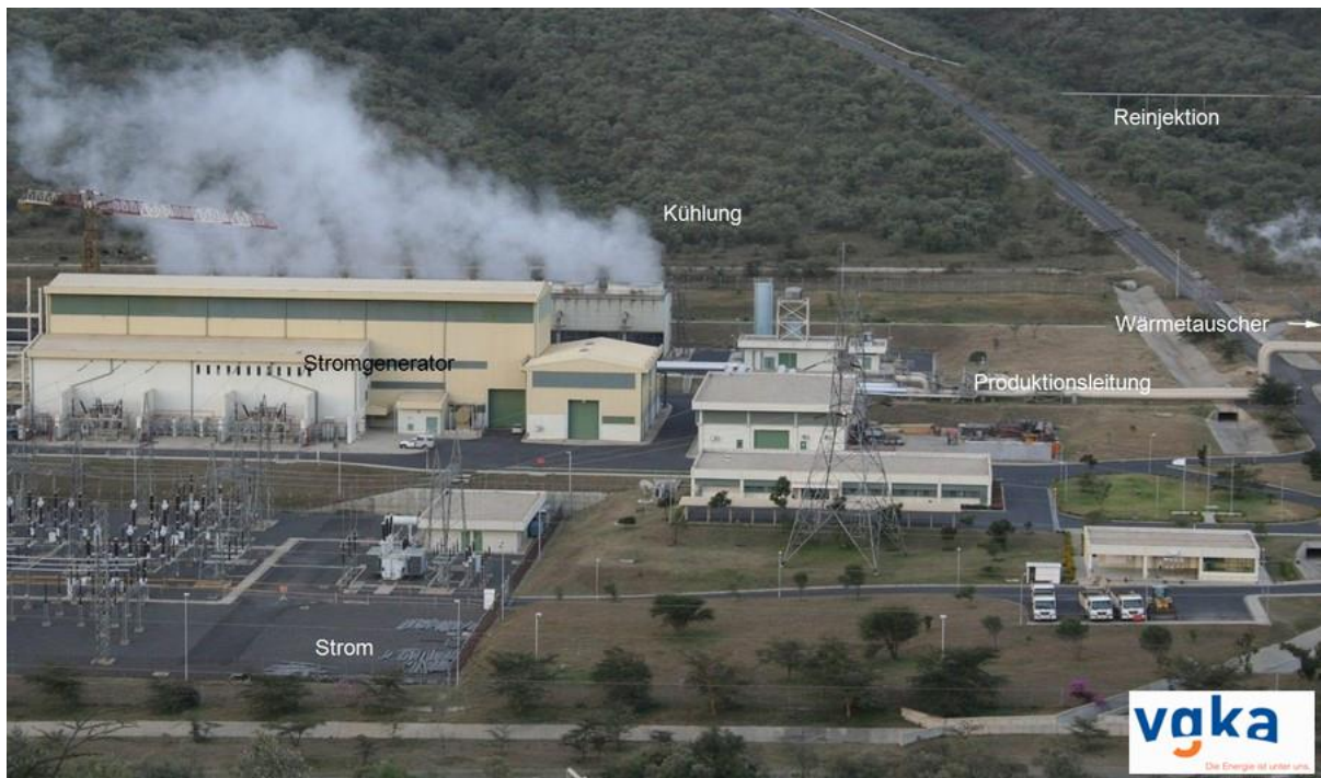
Abbildung 5: Luftaufnahme des geothermischen Kraftwerks Olkaria in Kenya.
