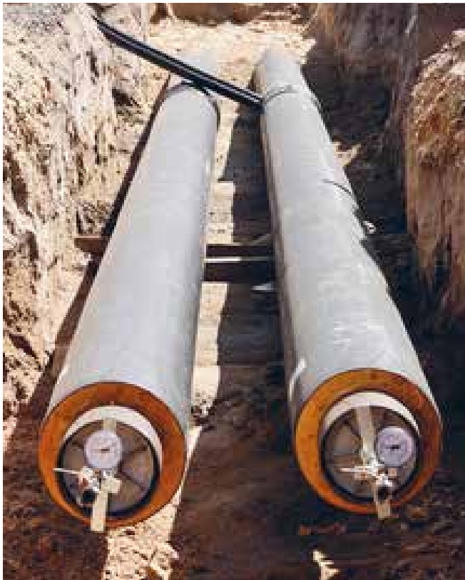
Verlegung neuer Fernwärmerohre
