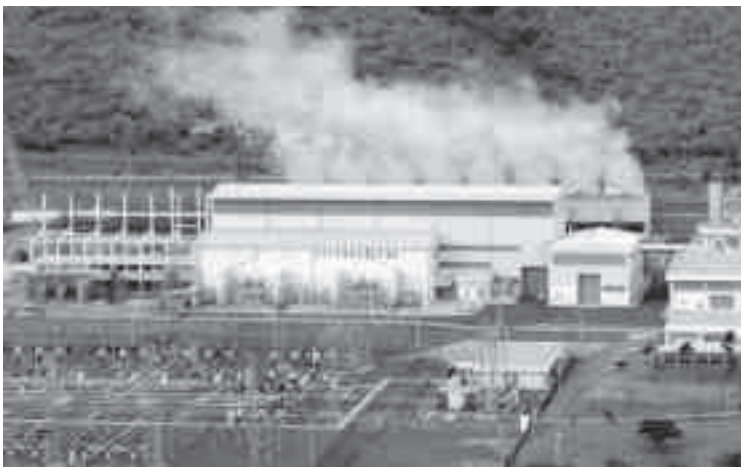
Anlage in Olkaria: 170 MW, Nassdampf.
