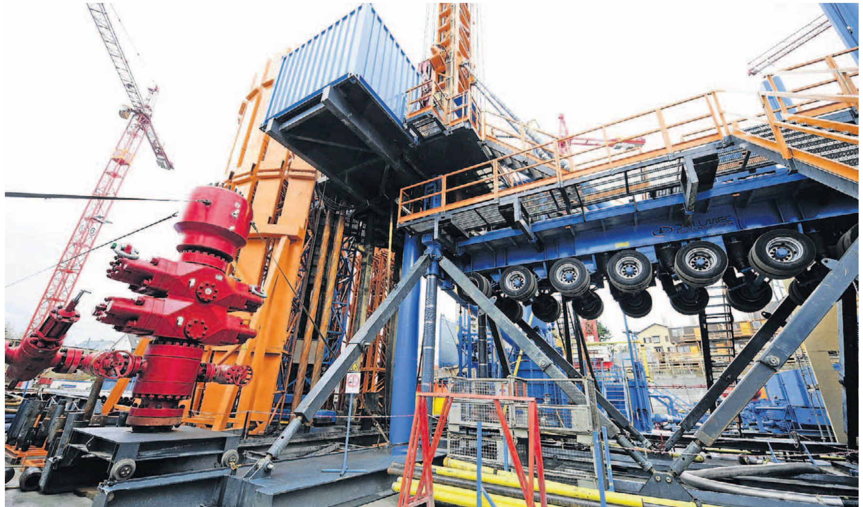
Geothermie-Erkundungsbohrung im Zürcher Triemli-Quartier.
